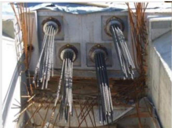
Die Kopfspanner einer Spannbetonbrücke
