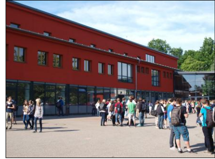
Gymnasium nach der Sanierung 2011
